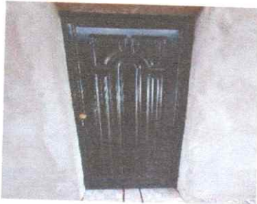
Foto 5: SUSTITUCIÓN DE PUERTA
