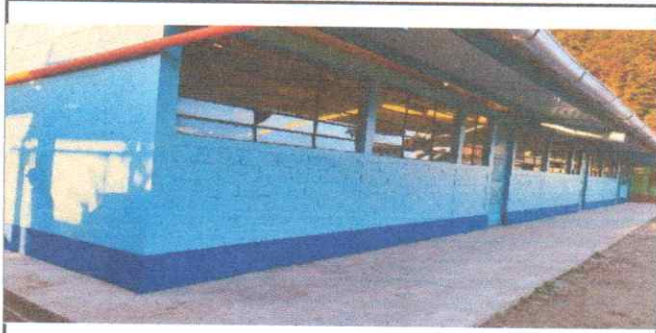
Foto7: pintura en aulas exteriores e interiores
