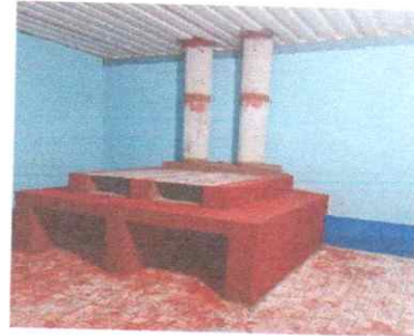
Foto 2: INSTALACIÓN DE ESTUFA RURAL (COMPLETA) INCLUYE CHIMINEA Y PLANCHA DE METAL
