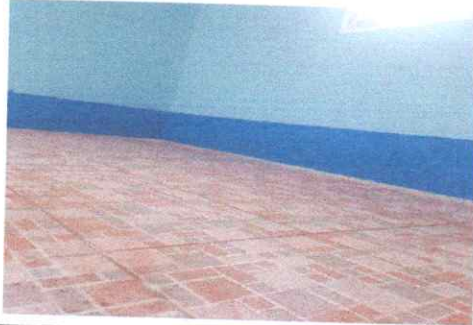
Foto 1: SUSTITUCIÓN DE PISO DE GRANITO
